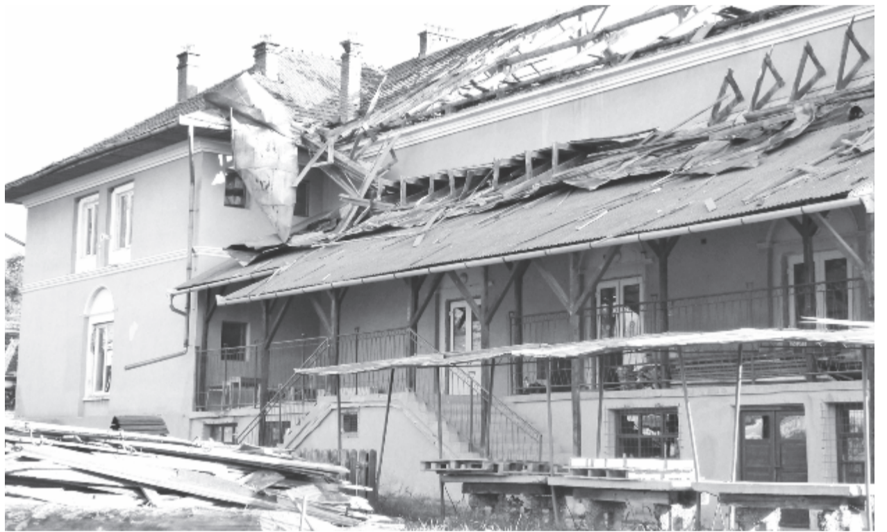
A tetőzetet is teljesen kicserélik, gyakorlatilag csak a falak maradnak meg a mostani épületből. Fotó: Gligor Róbert László
